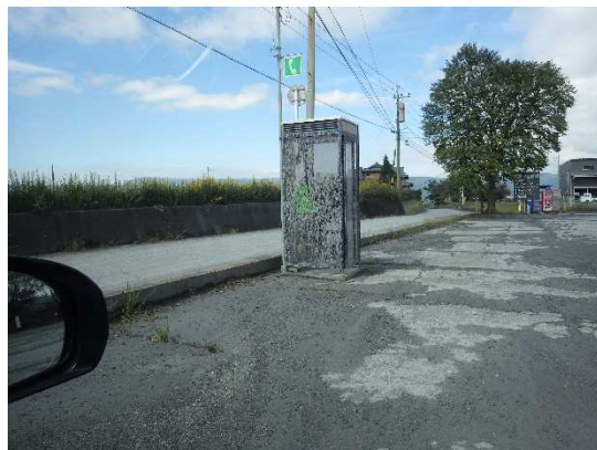
写真1 一ノ宮運動公園駐車場の降灰状況。 細粒の火山噴出物（火山灰）が中心。
