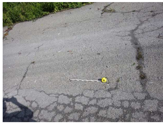
写真 6 161009-2 地点（宮地駅の南約 1.3 km 地点）. 礫が散在する.
